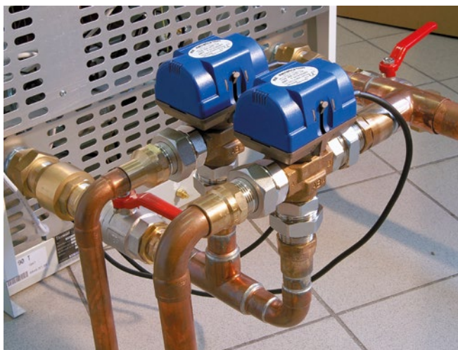
Подключение двух трёхходовых клапанов 1"
