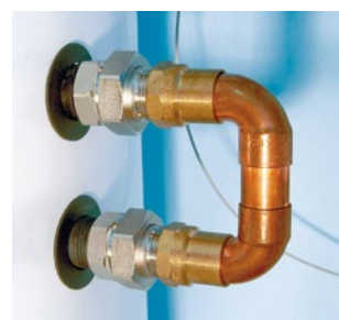
Соединение нагревательных элементов бойлера ГВС
