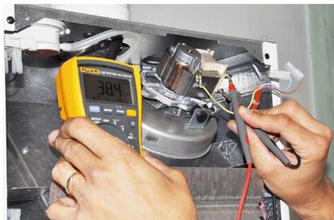
**Для котлов Main5, ECO-5 Compact** сопротивление на зажимах вентилятора 80 Ом(при 20°C). Сопротивление датчика температуры уходящих газов составляет 49 КОм(при 20 °С). Подробные характеристики датчика указаны в таблице на стр.91
